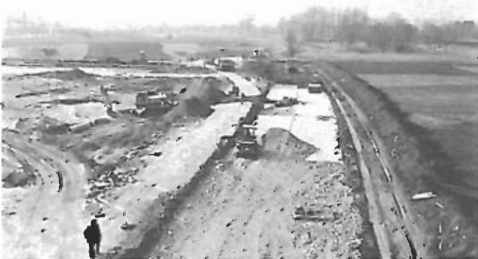
Baustelle Heusee im Frühjahr 1987
