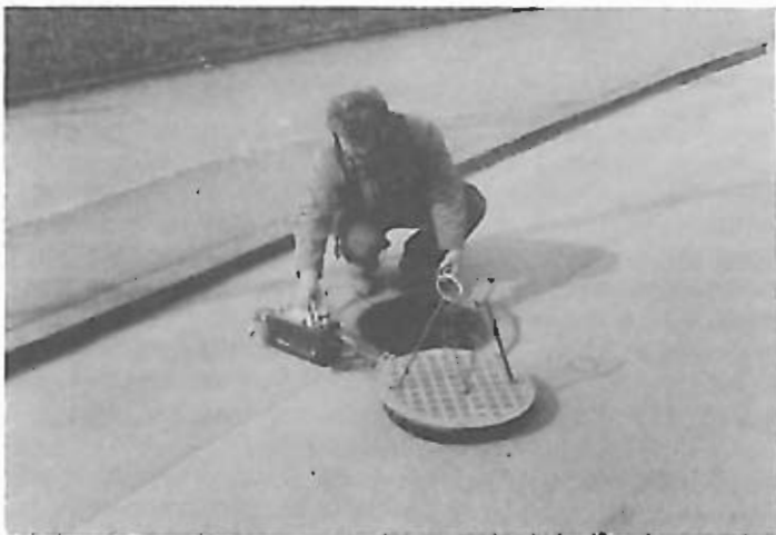
Wassersmeister Exner mit Horchgerät auf Rohrbruchsuche
