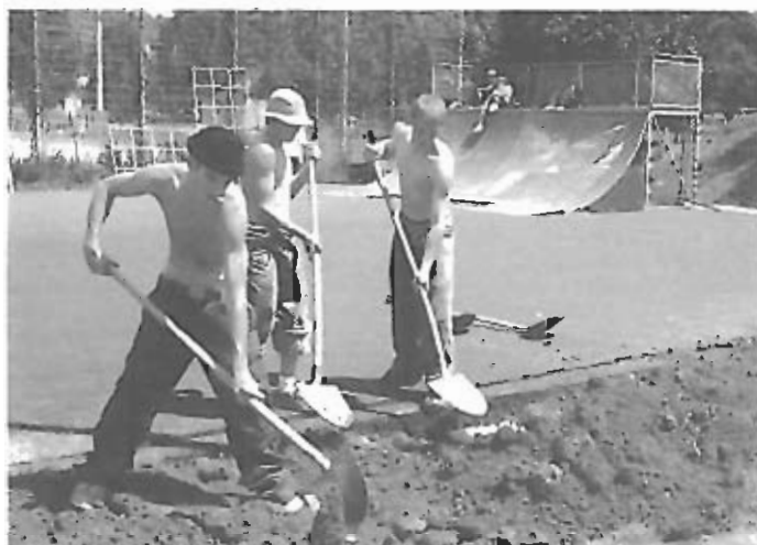
Fleißige Helfer beim Erstellen der Skateanlage
