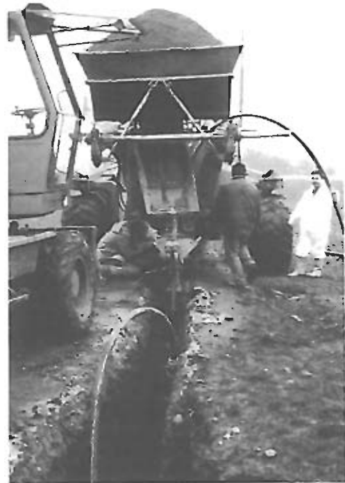
Der Schautenhof wird an die Wasserversorgung angeschlossen
